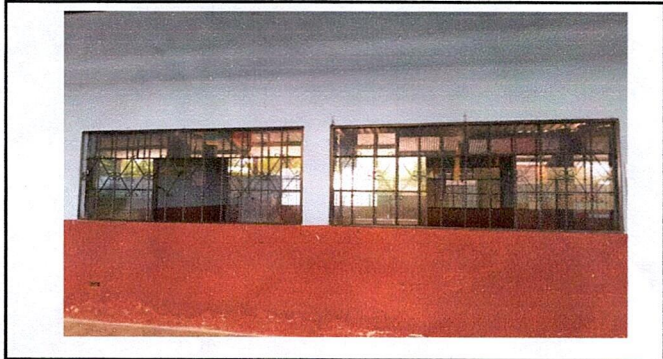
Foto 3: REPARACIÓN DE VENTANAS
