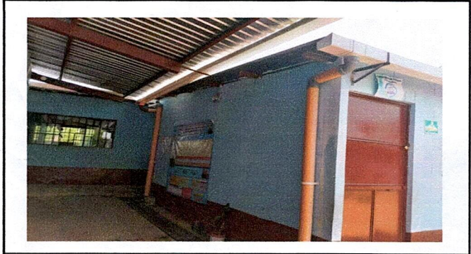
Foto 2: REPARACIÓN DE CAIDA DE AGUAS PLUVIALES
